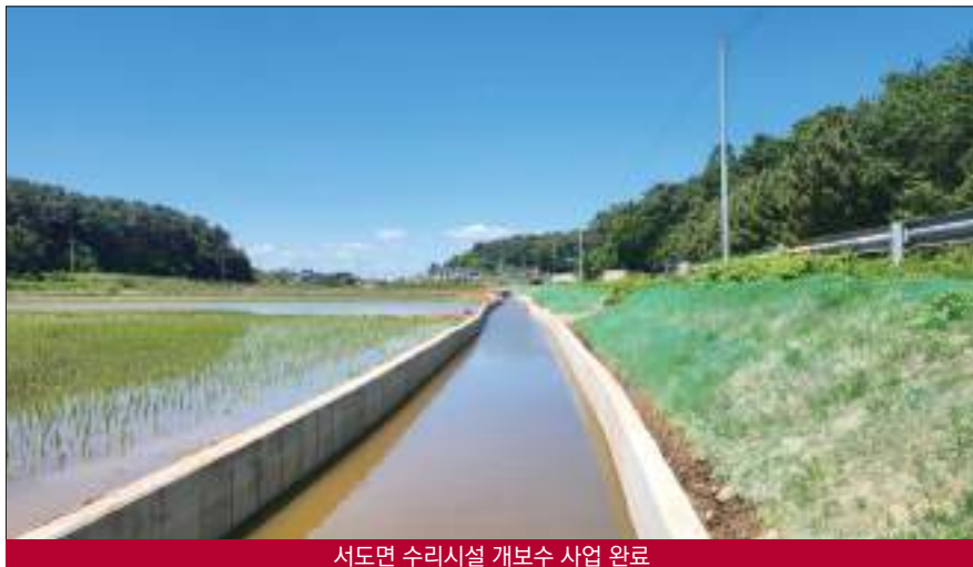
서도면 수리시설 개보수 사업 완료
